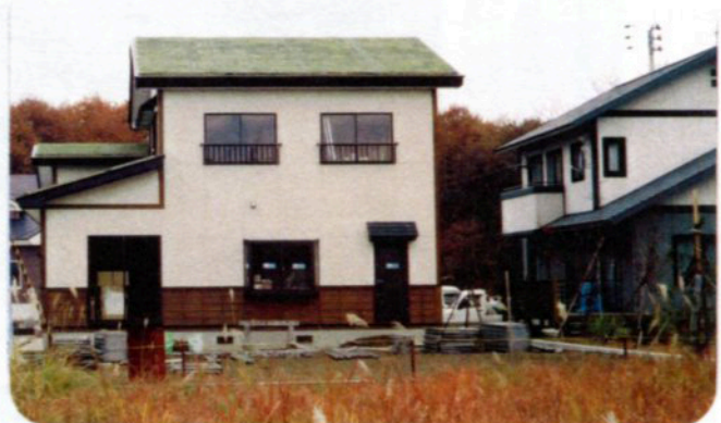
「緑化屋根完成」
