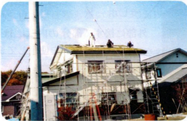
「ポーラスラピリ平板、スナゴケ設置」
